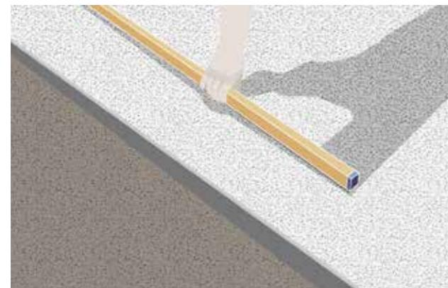
Nívele o substrato usando uma régua metálica.
