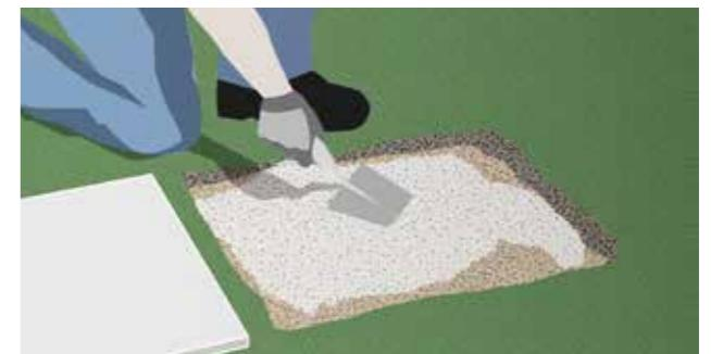
Forme um substrato uniforme utilizando a gravilha (grão entre 4 a 8mm).
