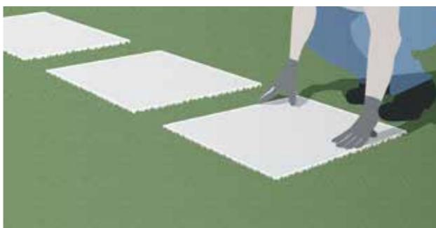
Aplique as placas cerâmicas de 20MM de modo a deixar cerca de 0,5cm de desnível entre a placa e o solo circundante.
