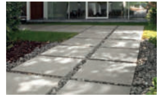
Posa su ghiaia . Installation onto gravel
