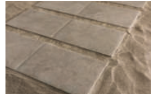
Posa su sabbia . Installation onto sand
